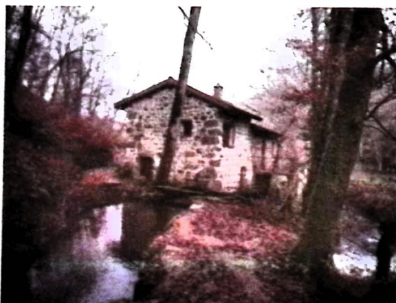
Moulin à chanvre sur la Commune de Saint-Oradoux
