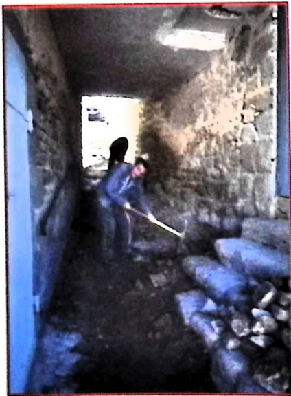
Pendant les travaux
